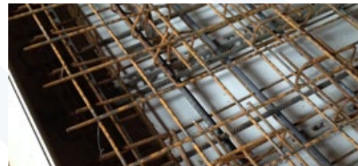
Boden- und Fundament- arbeiten
