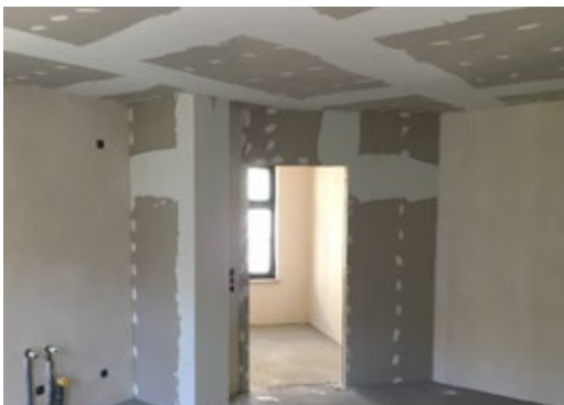
Ausbau mit Trockenbau
