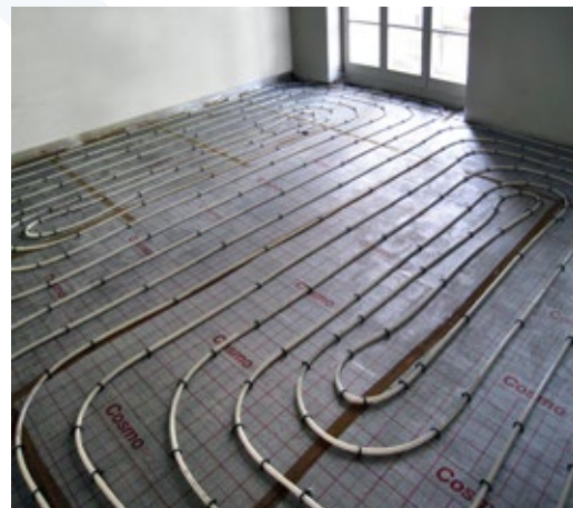
Fußboden- Heizung
